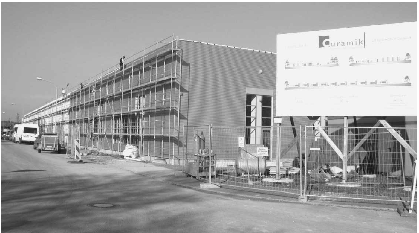
Rund 25 Millionen Euro investiert „curamik electronics“ in die neue Produktionshalle.
