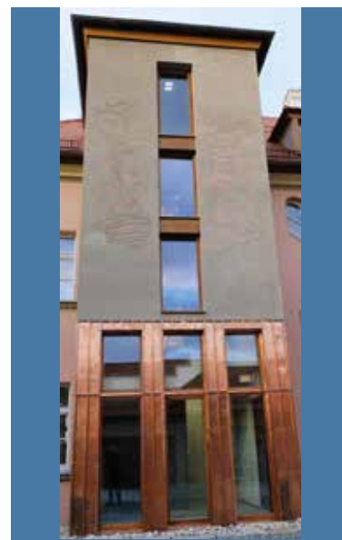
Die Außenfassade des Treppenhauses an der Südseite des Gebäudes überrascht mit kunstvollen Graffiti-Motiven in historischer Putz-Kratz-Technik.
