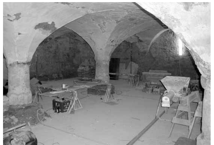
Die Restaurierung des Malzhauses schreitet zügig voran
