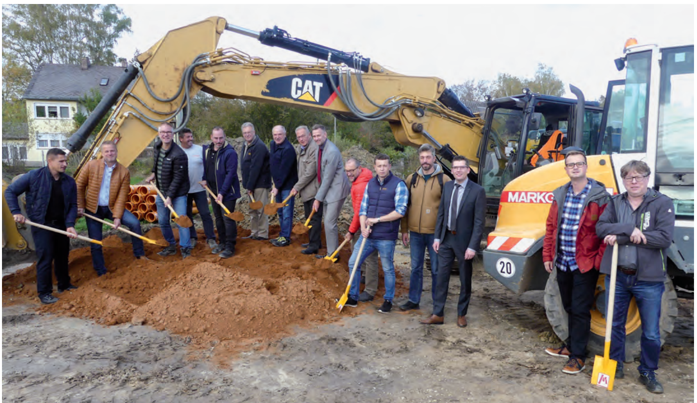
Spatenstich im neuen Baugebiet „Esperngasse Ost“
