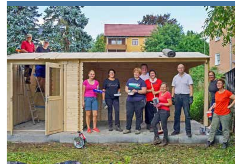
Viele fleißige Hände haben dazu beigetragen, das neue Gartenhaus fertigzustellen.
